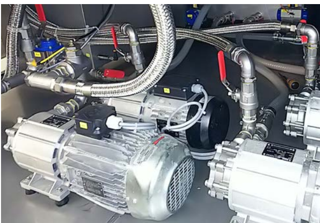
磁性不锈钢泵易于维护。此类泵无垫片，可杜绝漏水问题
